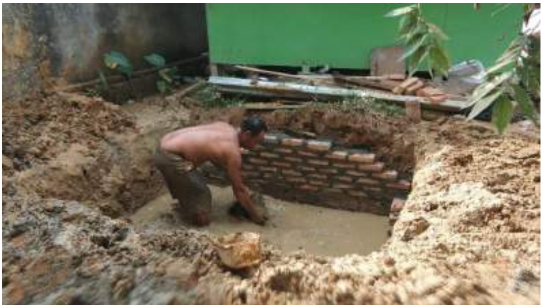
Gambar 4.4 Pembuatan Sumur Resapan dan Ground Water Tank
